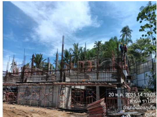
รูปที่ 3-66 นั่งร้านเหล็กรอบตัวอาคาร
