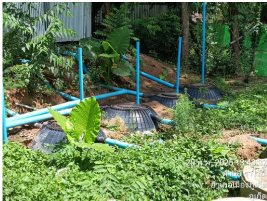
รูปที่ 3-41 ระบบบำบัดน้ำเสียชนิดเกราะ-กรองไร้อากาศ
