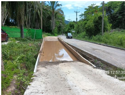
รูปที่ 3-23 พื้นที่สำหรับทำความสะอาดล้อรถบรรทุก
