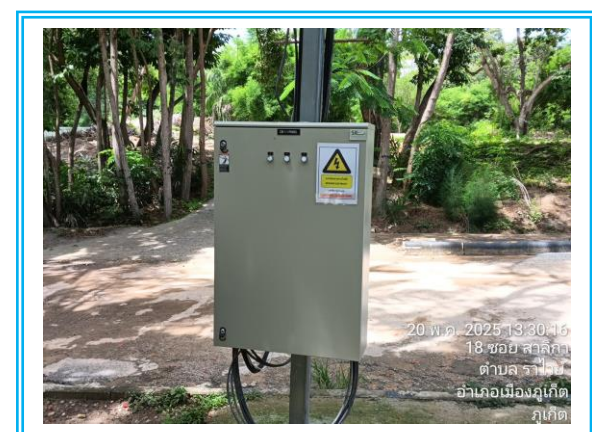
รูปที่ 3-60 อุปกรณ์ตัดไฟฟ้าอัตโนมัติ
