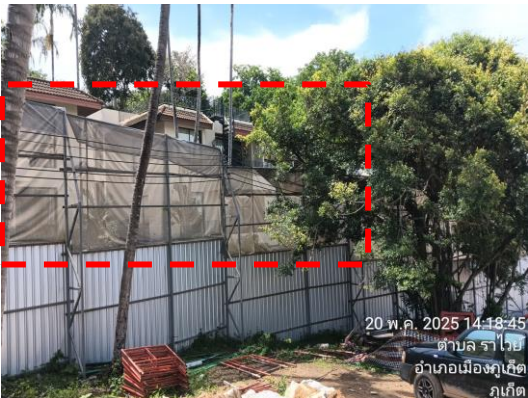
รูปที่ 3-18 ตาข่ายกันรอบพื้นที่ก่อสร้าง
