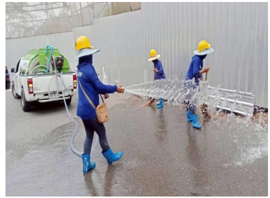
รูปที่ 3-22 ฉีดพรมน้ำบริเวณพื้นที่ก่อสร้าง
