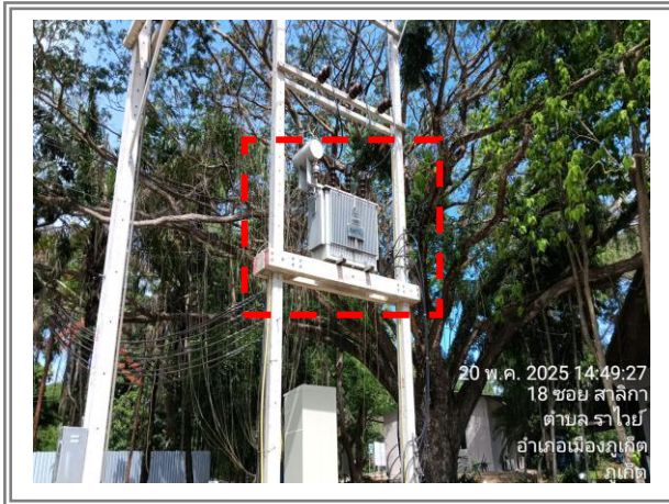
รูปที่ 2.4.7-1 หม้อแปลงไฟฟ้า
