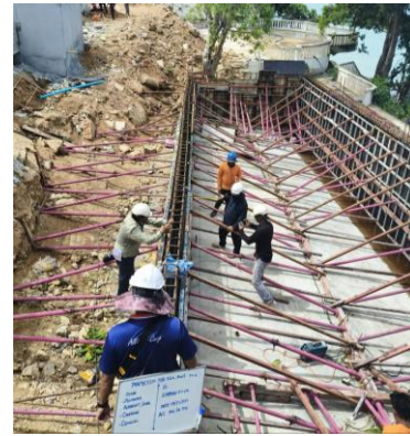
รูปที่ 3-5 ค้ำยันเหล็ก (steel bracing)
